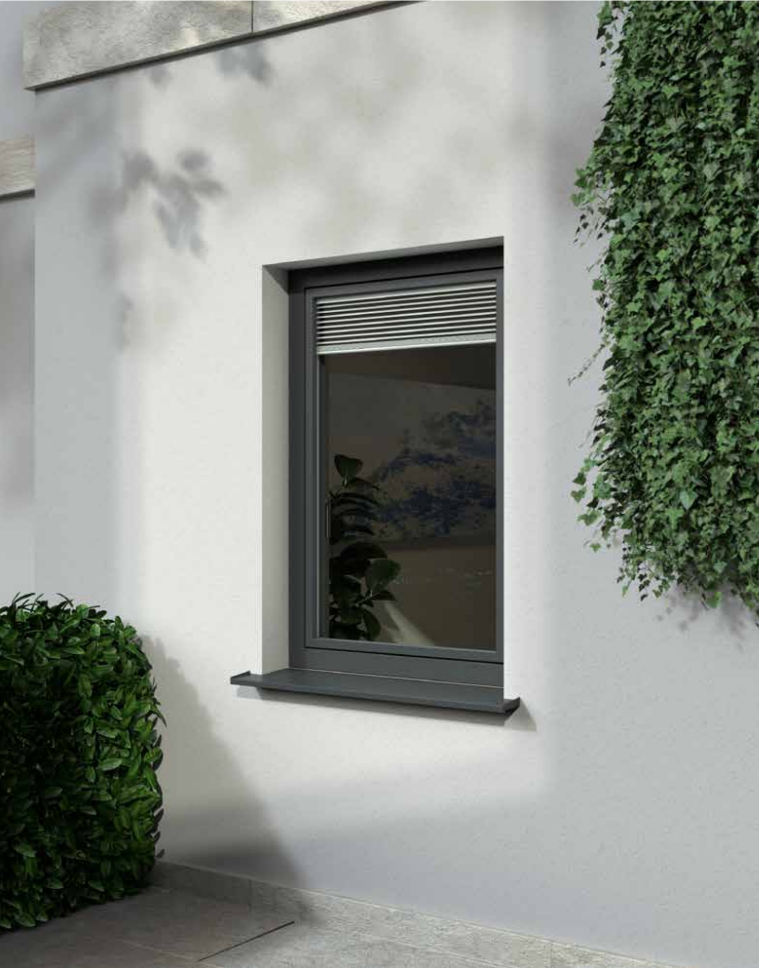
Fenêtre FIN-Window Slim-line Twin aluminium-PVC à un vantail, teinte M716 gris anthracite mat, store vénitien intégré teinte 0717 argenté, pièce d'appui en aluminium dans la teinte assortie.
